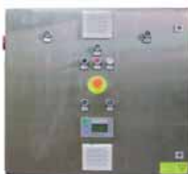
Ex-geschützte Sicherheitsschaltung (Schaltkasten außerhalb des Ex-Bereiches, Bedienung im Ex-Bereich)/ Explosion-proof safety control (Control cabinet in a safe area, operation panel in hazardous area)
